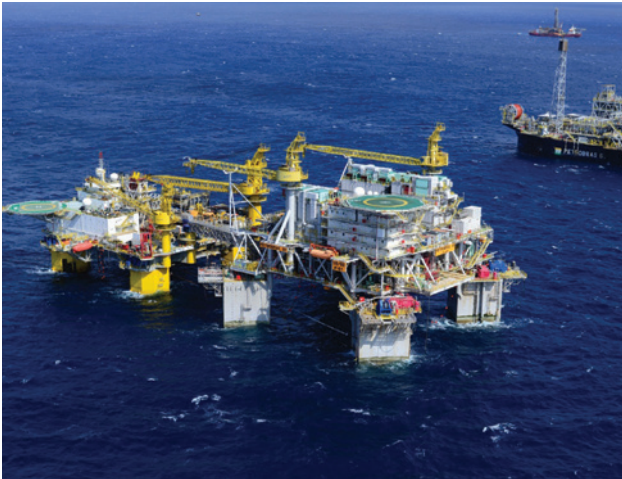
Figura 4.13: Plataforma p-61 e a unidade –flutuante p-63, no campo de Papa-Terra, localizado no extremo sul da Baía de Campos-RJ Fonte: www.epocanegocios.globo.com
